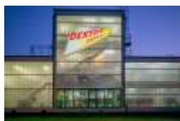
Dextro Energy Produktionshalle Quelle: Zertus GmbH
