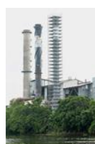
Layher Allround-Gerüst Höhenzugang Revisionsarbeiten
