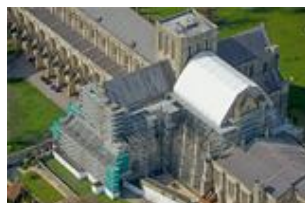
Layher Allround-Gerüst Kederdach XL_Sanierung Winchester Cathedral
