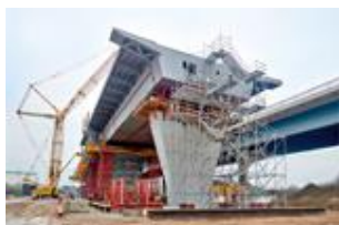
Layher Allround-Gerüst Brückenbau
